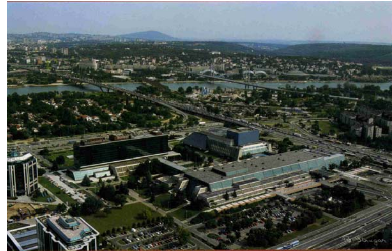
Sl. 2 – Centar Novog Beograda oko 1980 godine. Proračunski Joule -ovi gubici u mrežama 110 kV, 10 kV i 0,4 kV su reda 2,5 % u toku jedne kalendarske godine (obračun preuzete električne energije je u sabirnicama 10 kV u TS 10/0.4 kV)
